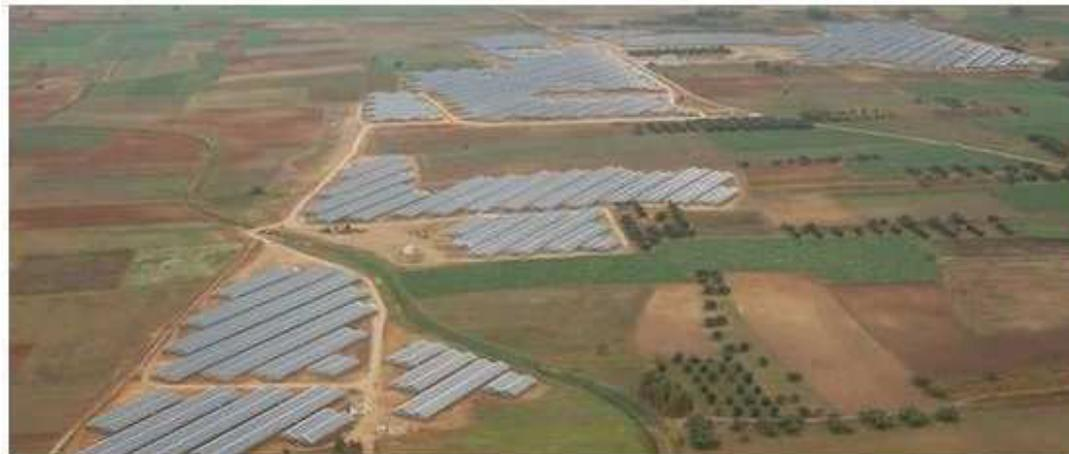
Compiono un anno le serre fotovoltaiche di Villasor, nel sud Sardegna, a 25 km da Cagliari, uno degli impianti solari più grandi del mondo. 26 ettari di terreno, 134 serre, 84.000 pannelli in silicio policristallino (20 Mwp installati, pari al consumo annuale di 10.000 case) che consentono un risparmio di 25mila tonnellate di CO2 in atmosfera (equivalente alla capacità di assorbimento di una foresta di 3.200 ettari).
